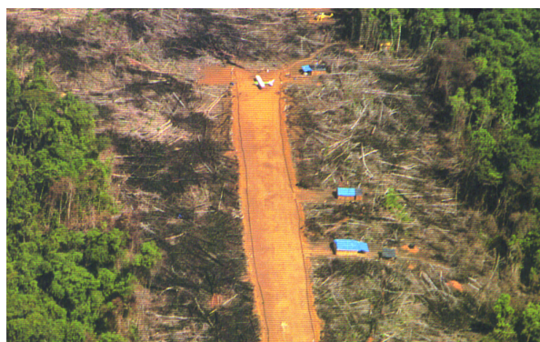
TALA DE ÁRBOLES PARA LA CONSTRUCCIÓN DE CARRETERAS.
